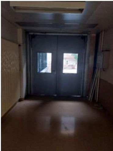
Neueinbau Toranlage „Liegeneinfahrt“
